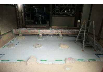
④捨コンクリート打設
