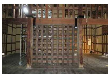
⑯米蔵補強格子取付完了
