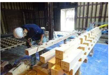
⑮米蔵補強格子加工中
