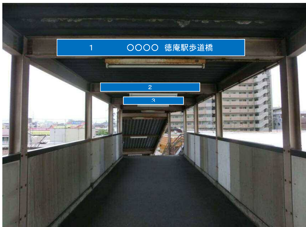
階段下り7箇所(写真位置の青枠箇所)
