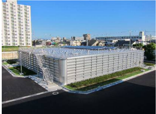
上小阪配水場
