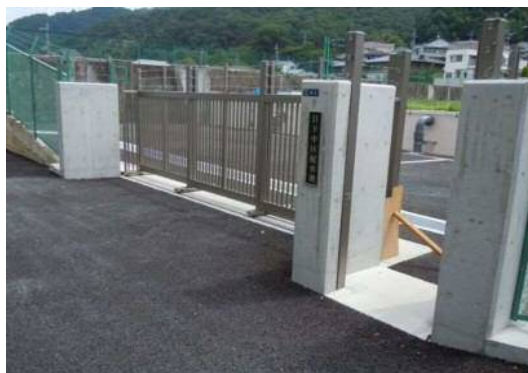
日下中区配水池
