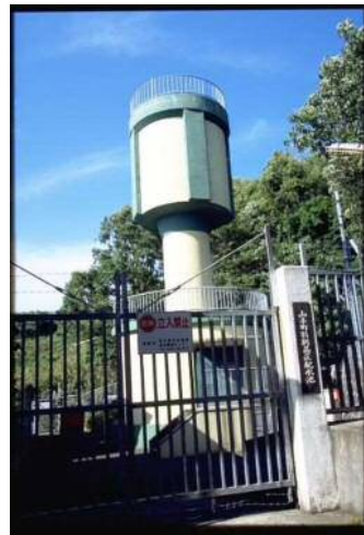
山手町特別高区BC配水池
