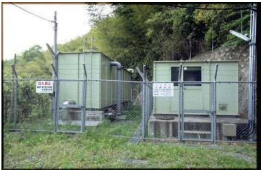
上石切町特別高区A配水池
