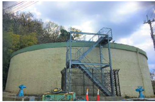
五条中区配水池
