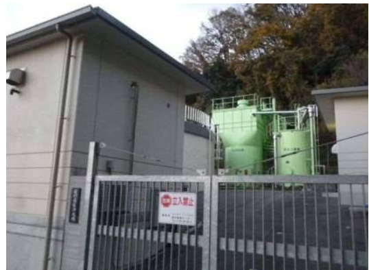
石切高区浄水場
