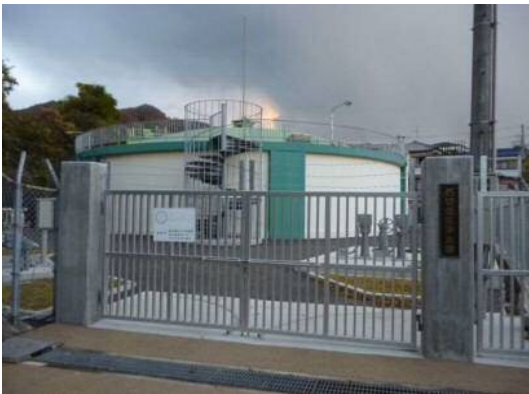
石切低区浄水場
