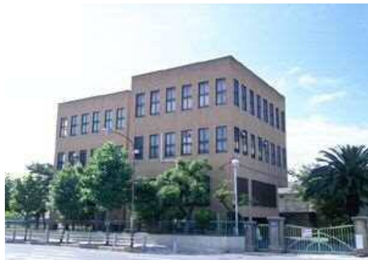
菱屋西配水場
