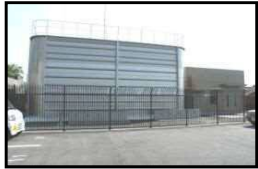
六万寺配水池
