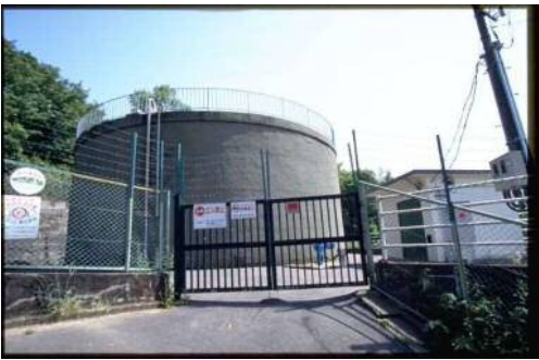
上四条高区配水池
