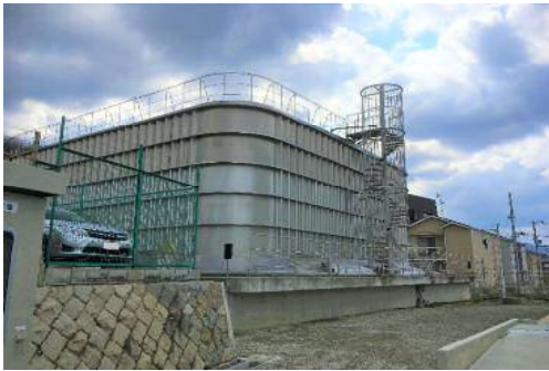
五条低区配水池
