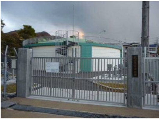
石切低区浄水場
