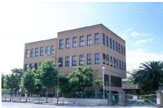
菱屋西配水場
