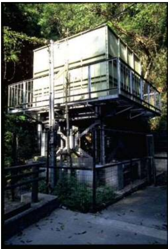
山手町特別高区A配水池
