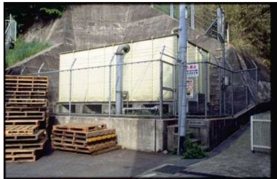
上石切町特別高区B配水池
