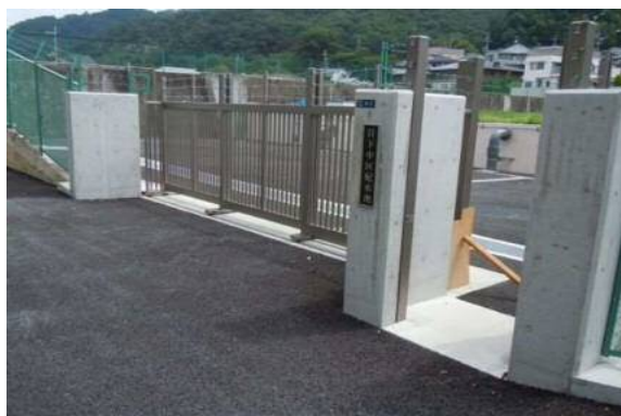
日下中区配水池
