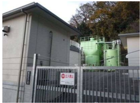
石切高区浄水場
