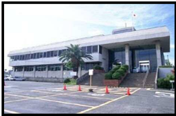
東大阪市上下水道局水道庁舎
