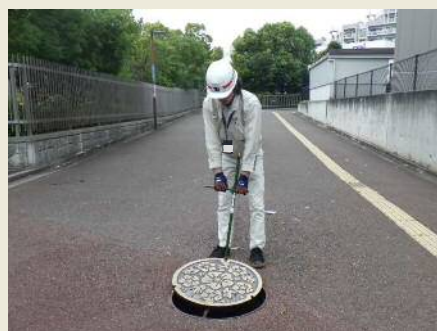
～マンホールの蓋開け～
