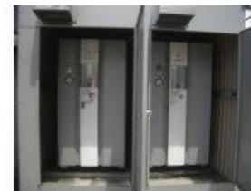
貫流ボイラ：2台 蒸気量：2t/h 都市ガス13A
