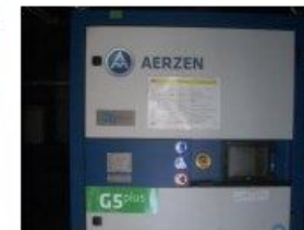
曝気用高効率プロワ：1台 吐出圧力：8000kPa
