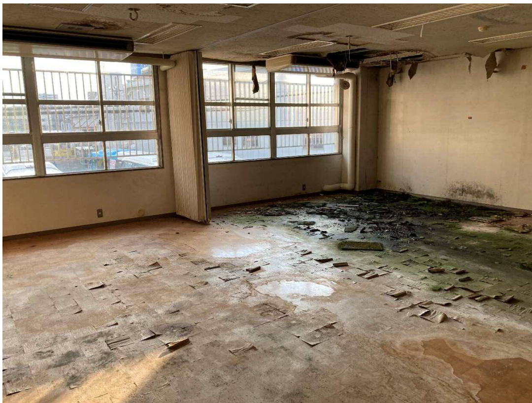
(57) 2階 会議室（北東から南西方向）
