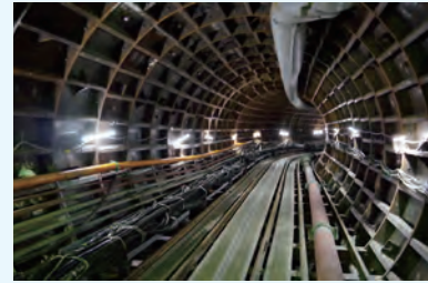
新岸田堂幹線(施工中)
